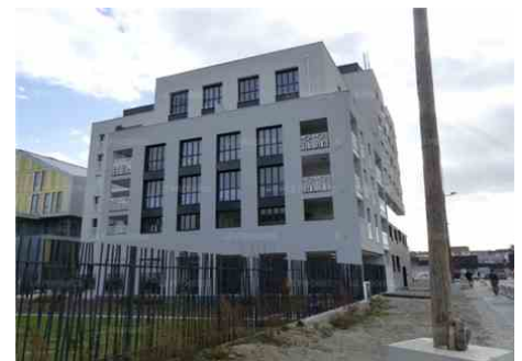
Résidence « SO CITY » 63 logements Coût de l'opération 7.106 K€ Photo Progrès /Jean Marc MANIFICAT
