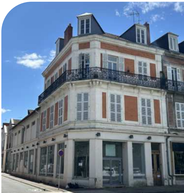
En 2025, l'agence Lagrue investira de nouveaux bureaux en plein cœur de Vichy (03)
