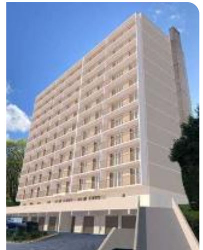
Projet de rénovation énergétique, Lyon 9e
